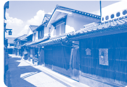
御手洗町並み保存地区(大崎下島) 江戸時代、風待ち・潮待ちの港町として栄えた御手洗には、大小の商家、茶屋、陣宿、神社、寺院など、江戸中期から幕末の面影をとどめる建物が数多く残されており、獨特の雰囲気を醸し出しています。平成6年、重要伝統的建造物群保存地区として国から選定されています。
